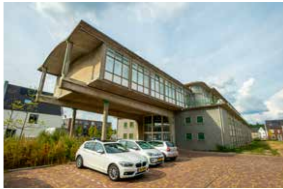
Het ENKA-terrein, tegenwoordig een woonwijk. De beschikbaarheid van schoon grondwater uit de 'waterkelder' van de Veluwe, maakte de vestiging van de kunstzijdefabriek aantrekkelijk.
